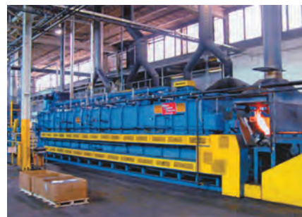
图3 紧固件硬化与表面硬化之网带输送连续炉
